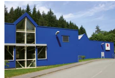
Werk 2 – Mellenbach Elektronikfertigung
