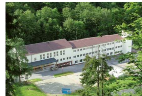
Werk 3 – Unterweißbach Transformatorbau
