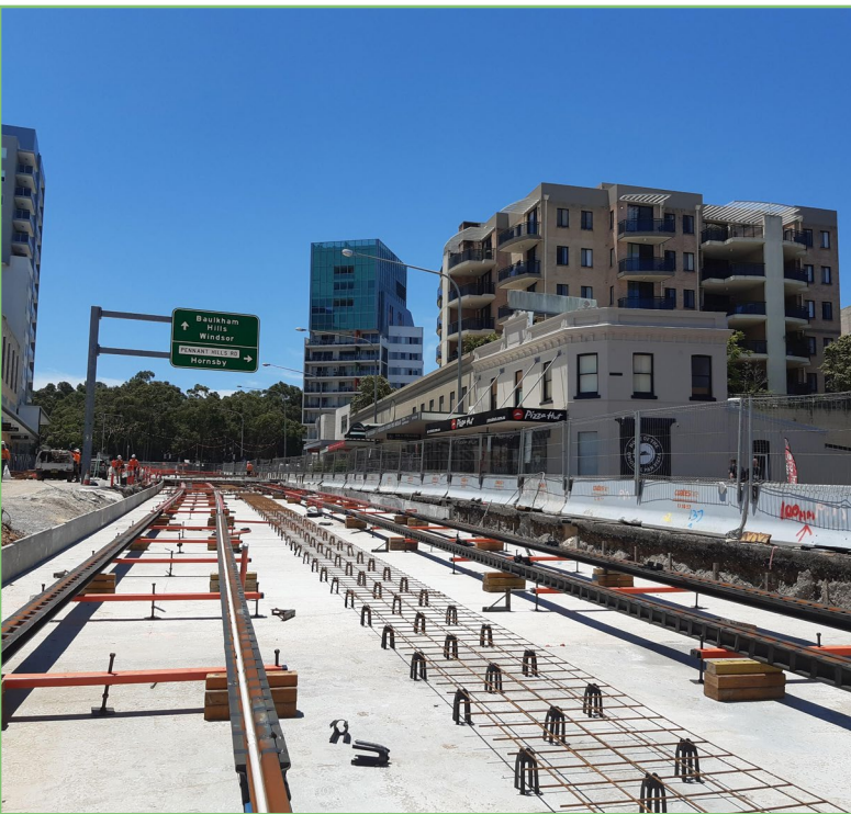
Fennell St Church St - Track Pour Section
